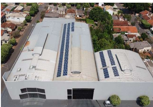
Figura 7 – Instalação Distribuidora Dalla Valle
