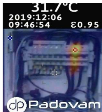
Figura 10 – Inspeção com Termômetro Visual
